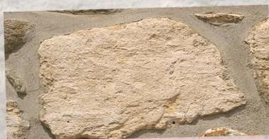
**Le calcaire:** roche très localisée dans le Cantal, utilisée en remplissage de murs ou en entourage d'ouvertures. Ce calcaire se taille aisément et contient parfois des fossiles de mollusques qui vivaient en milieu d'eau douce ou saumâtre, dans le bassin d'Aurillac.
